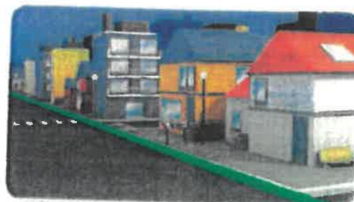
Ci-dessus, le panneau est situé trop en aval de l'agglomération.
