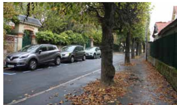
Rue des Vallées, après rénovation
